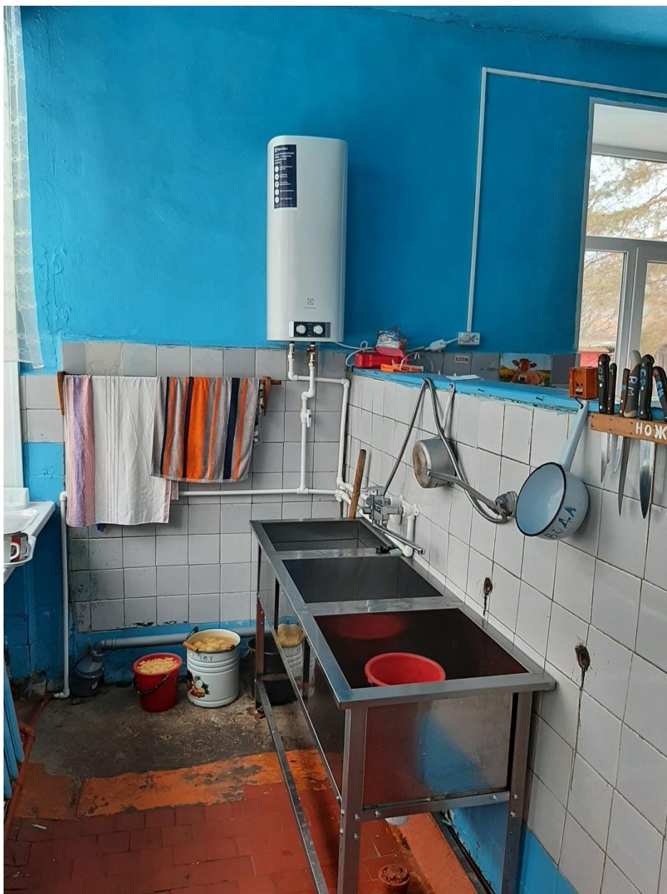
5,6. Установка умывальников и моек
