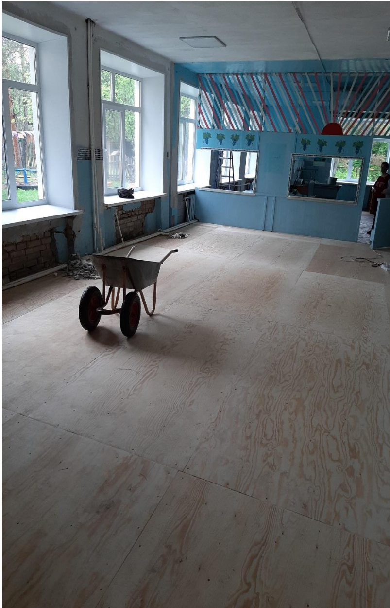
2,3 Ремонт пола в столовой
