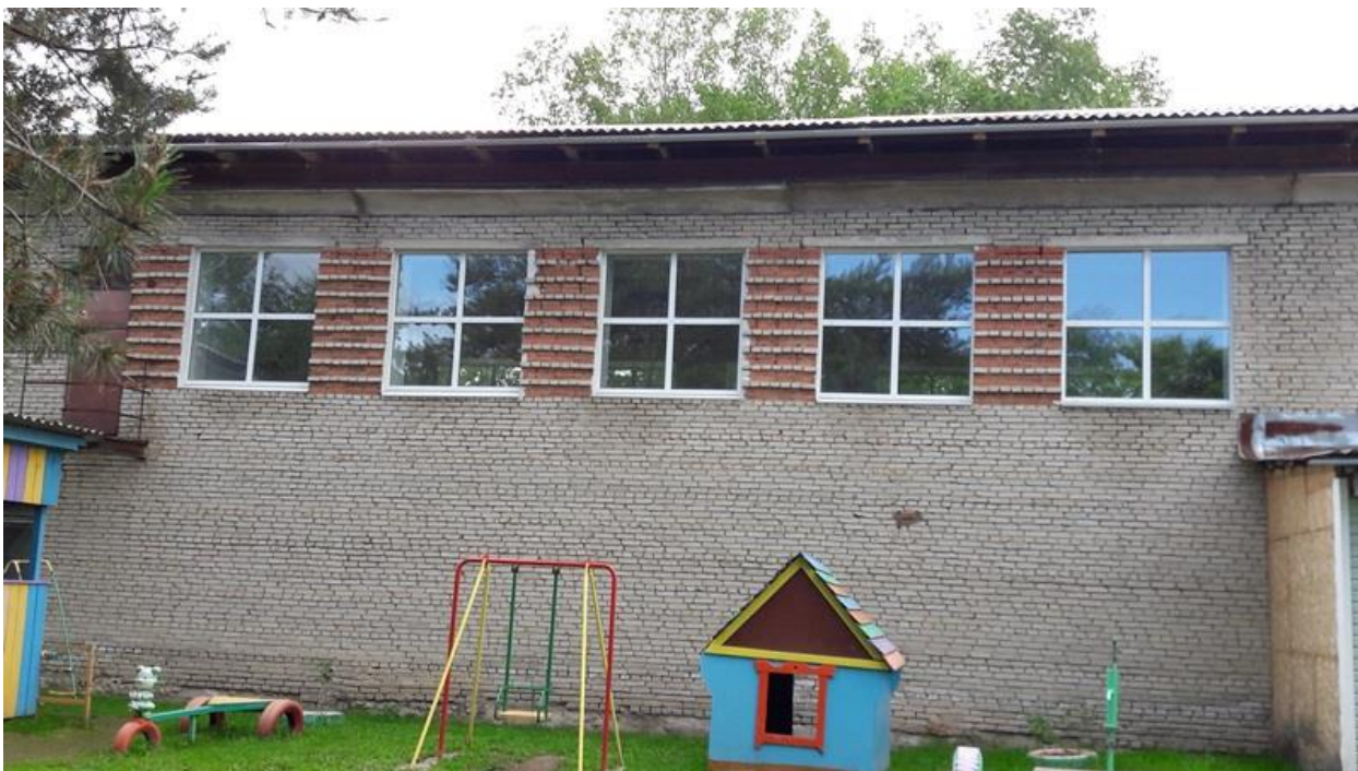
3. Замена окон в спортзале
