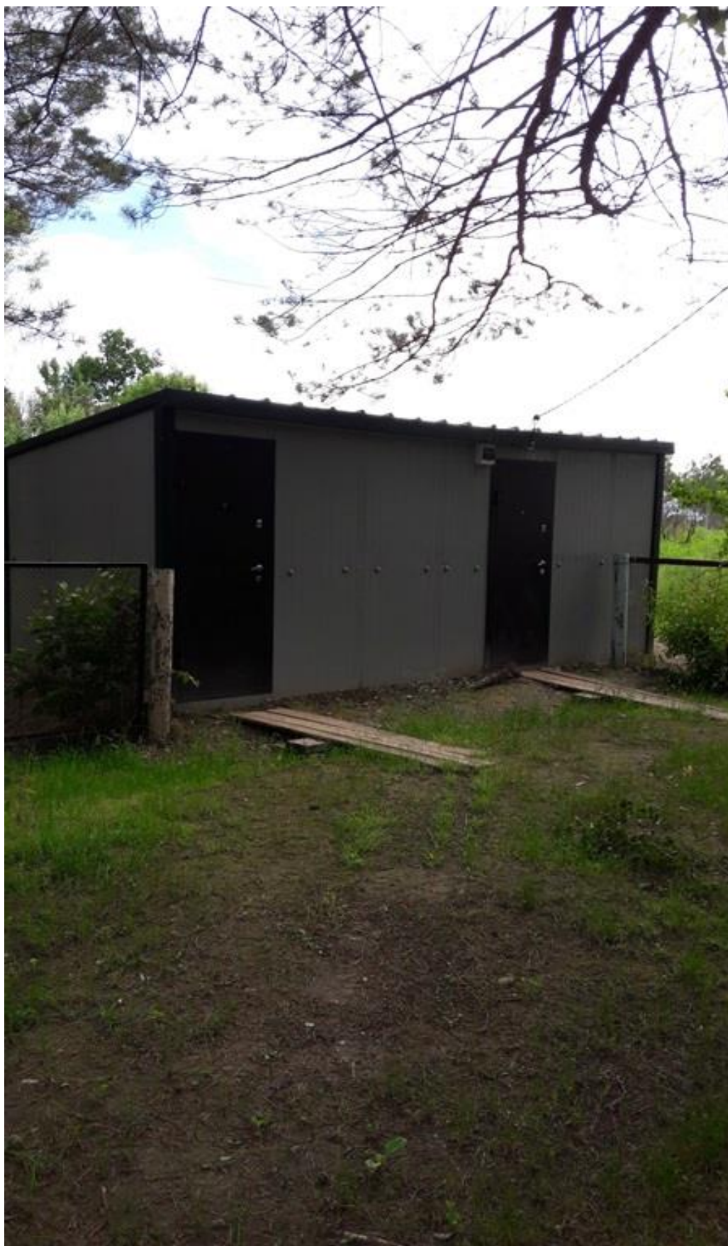
1. Устройство теплого туалета
