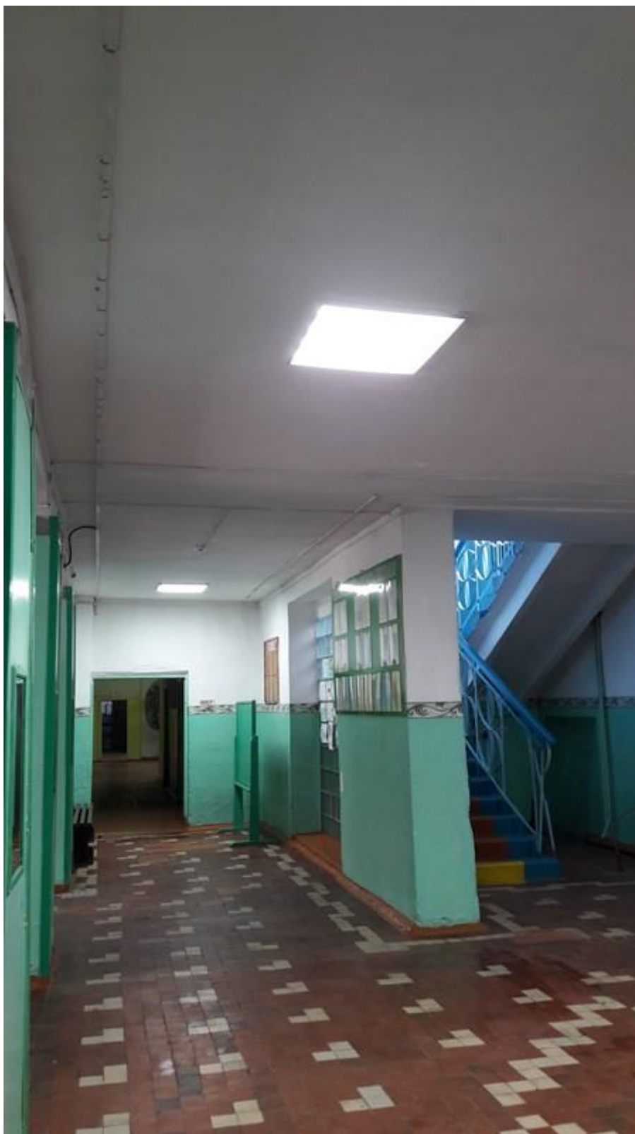
2. Замена освещения на 1 этаже.
