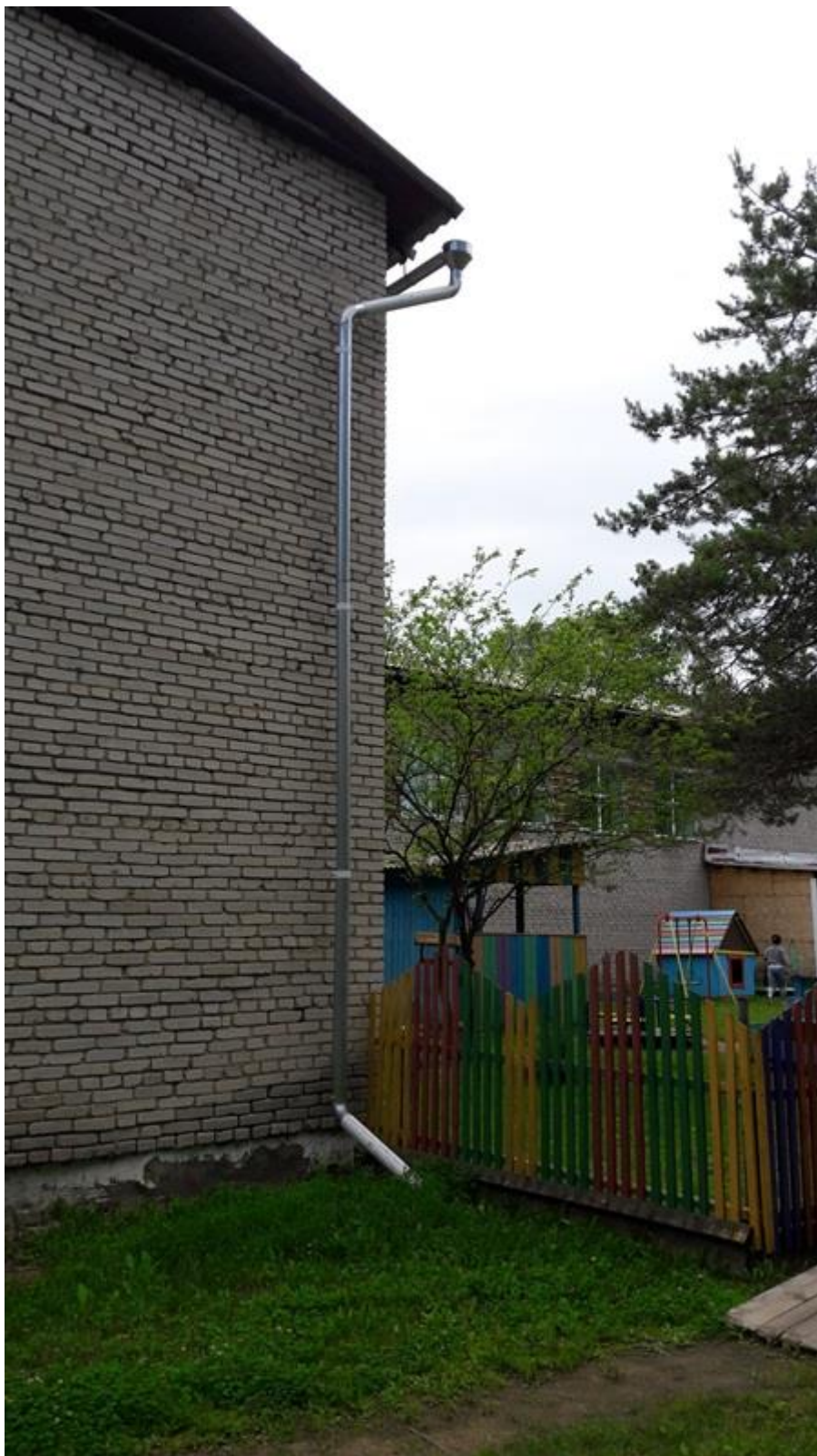
4. Установка водоотливов по периметру здания
